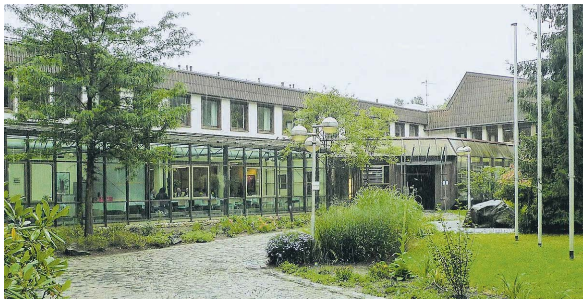
So sieht noch der gegenwärtige Eingangsbereich des Bildungszentrums der Arbeitskammer in Kirkel aus. Das Haus ist sowohl Schulungs- als auch Kulturzentrum. FOTO: THORSTEN WOLF
