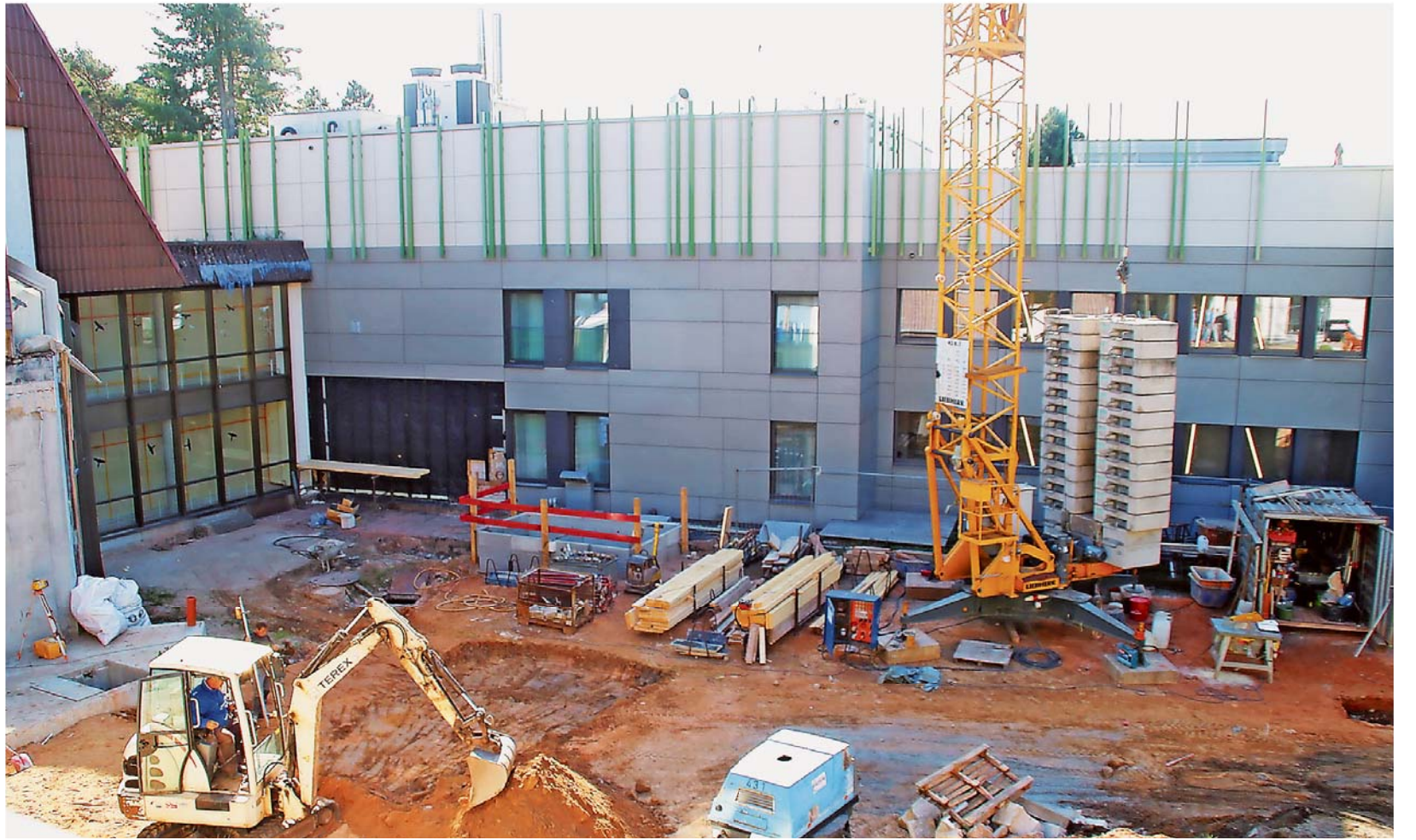
Ein Blick auf die Baustelle am Bildungszentrum der Arbeitskammer in Kirkel Mitte September.
